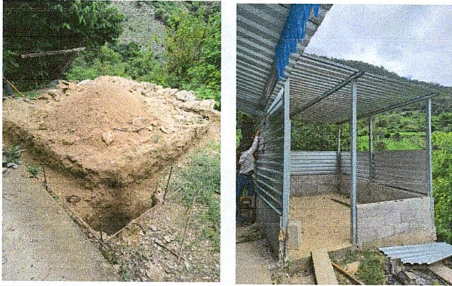
Fotos 1: Mejoramiento de área de servicio de cocina.
