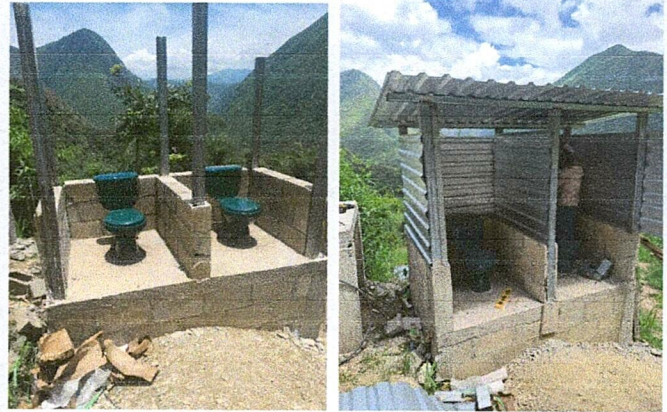
Fotos 2: Mejoramiento de área de servicio de sanitario
